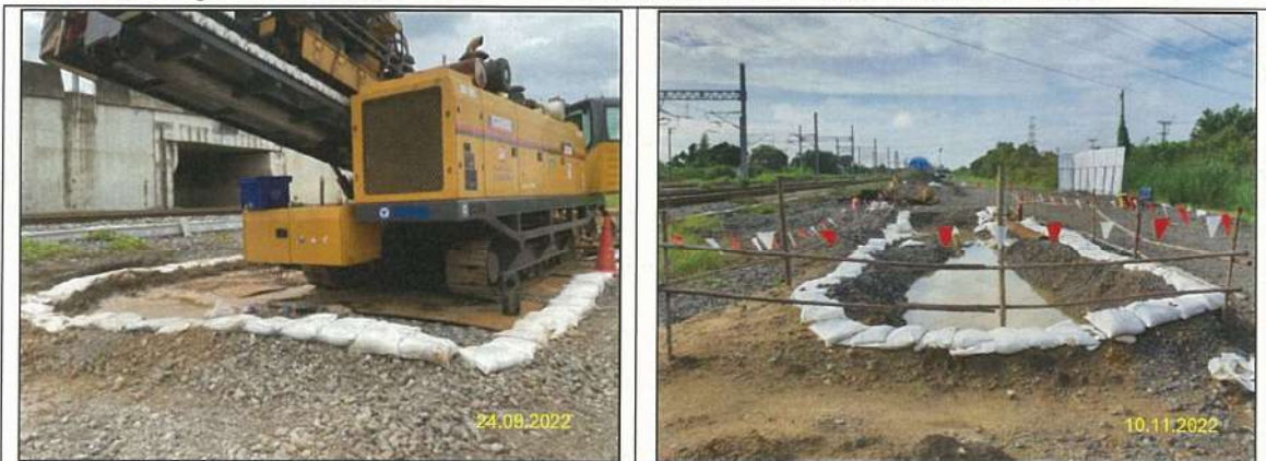
รูปที่ 2-21 การจัดวางถุงทรายหรือทำคันดินกันรอบพื้นที่บ่อรับ-ปล่อย
