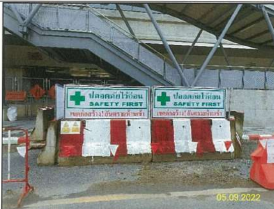
ง) ติดตั้งรั้วกำแพงคอนกรีต (Concrete Barrier) รอบบ่อรับและบ่อส่ง พร้อมป้ายเตือนเขตหวงห้าม
