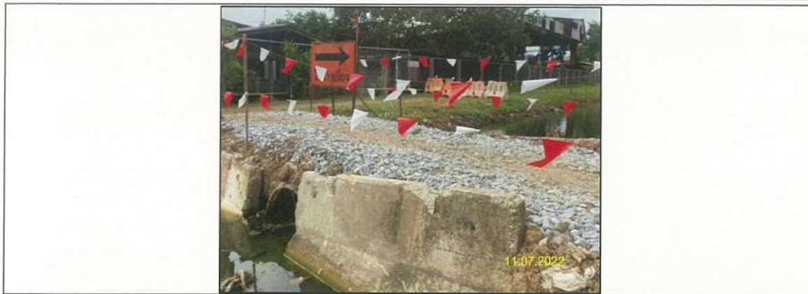
รูปที่ 2-22 การทำทางเบี่ยงเบนทิศทางการไหลของน้ำชั่วคราว
