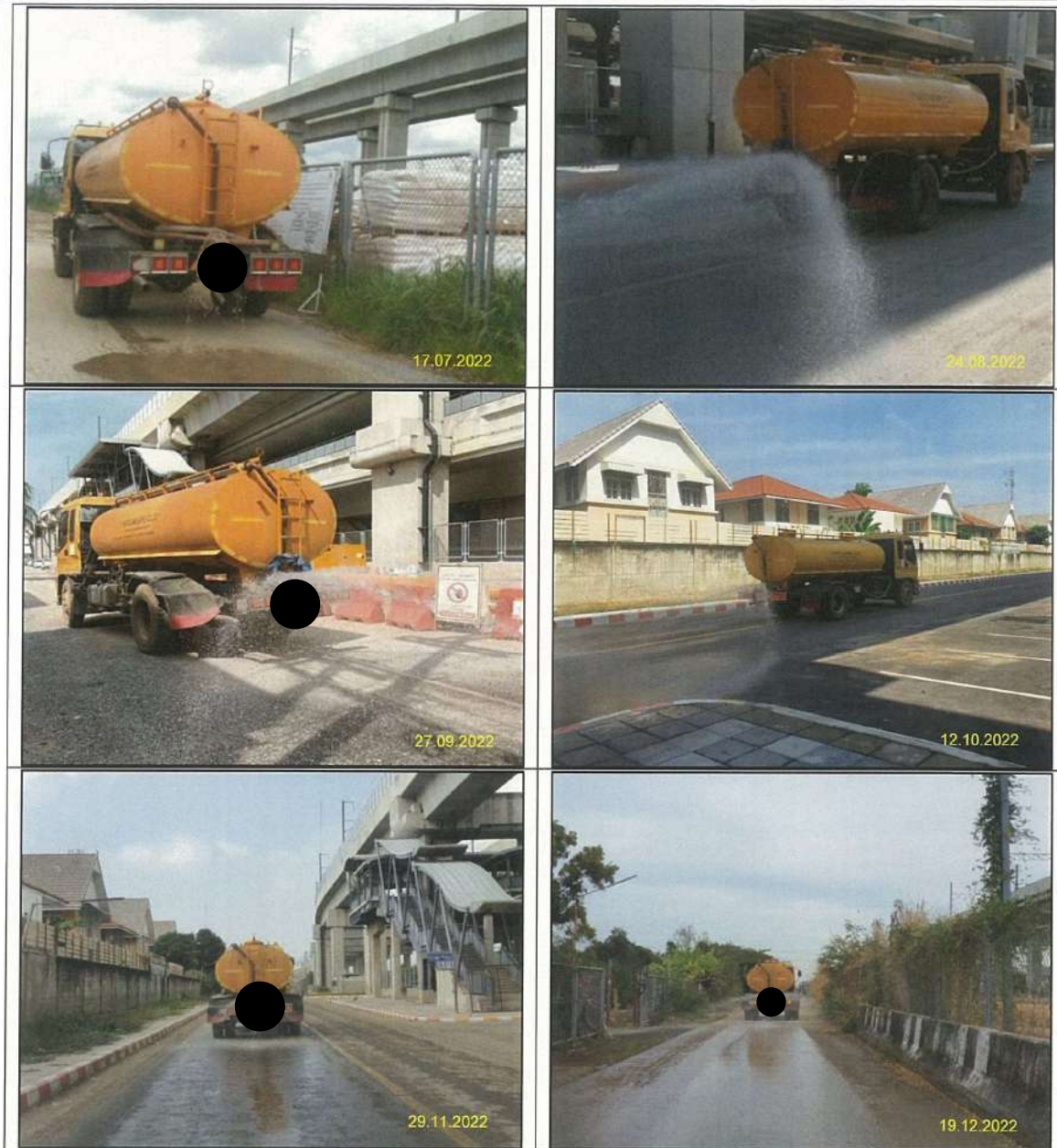
รูปที่ 2-3 การฉีดพรมน้ำบริเวณพื้นที่ก่อสร้างและเส้นทางคมนาคมในบริเวณใกล้เคียงพื้นที่ก่อสร้าง
