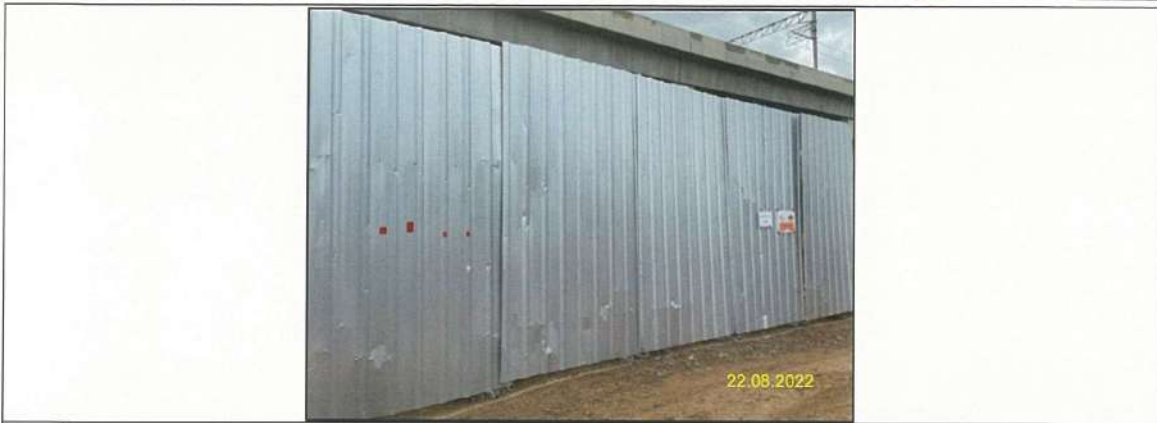
(5) พื้นที่ก่อสร้าง (บ่อส่ง Boring5 จุดส่ง HDD3 และจุดส่ง HDD4) บริเวณบ้านพักอาศัยหมู่ที่ 2 บ้านคลองเปรมประชากร รูปที่ 2-10 (ต่อ) การติดตั้งกำแพงกันเสียงชั่วคราว
