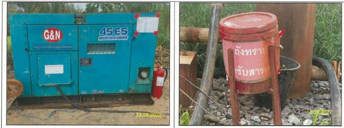
รูปที่ 2-16 การจัดเตรียมถาดเก็บรองรับน้ำมัน และวัสดุดูดซับ
