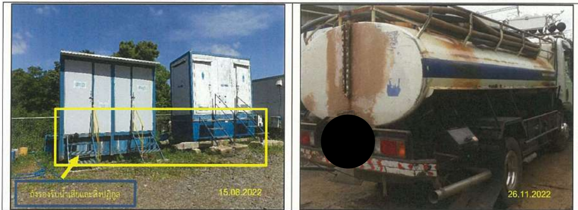
รูปที่ 2-14 ท่อน้ำและถังรองรับน้ำเสียและสิ่งปฏิกูลในบริเวณพื้นที่ตั้งสำนักงานชั่วคราว/พื้นที่เก็บกองท่อ
