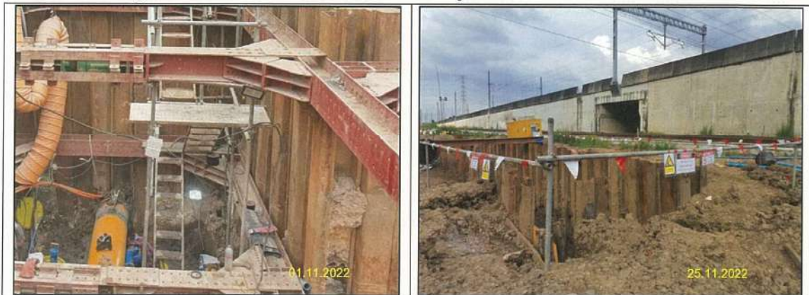
รูปที่ 2-12 การติดตั้ง Sheet Pile เพื่อป้องกันการพังทลายของดิน
